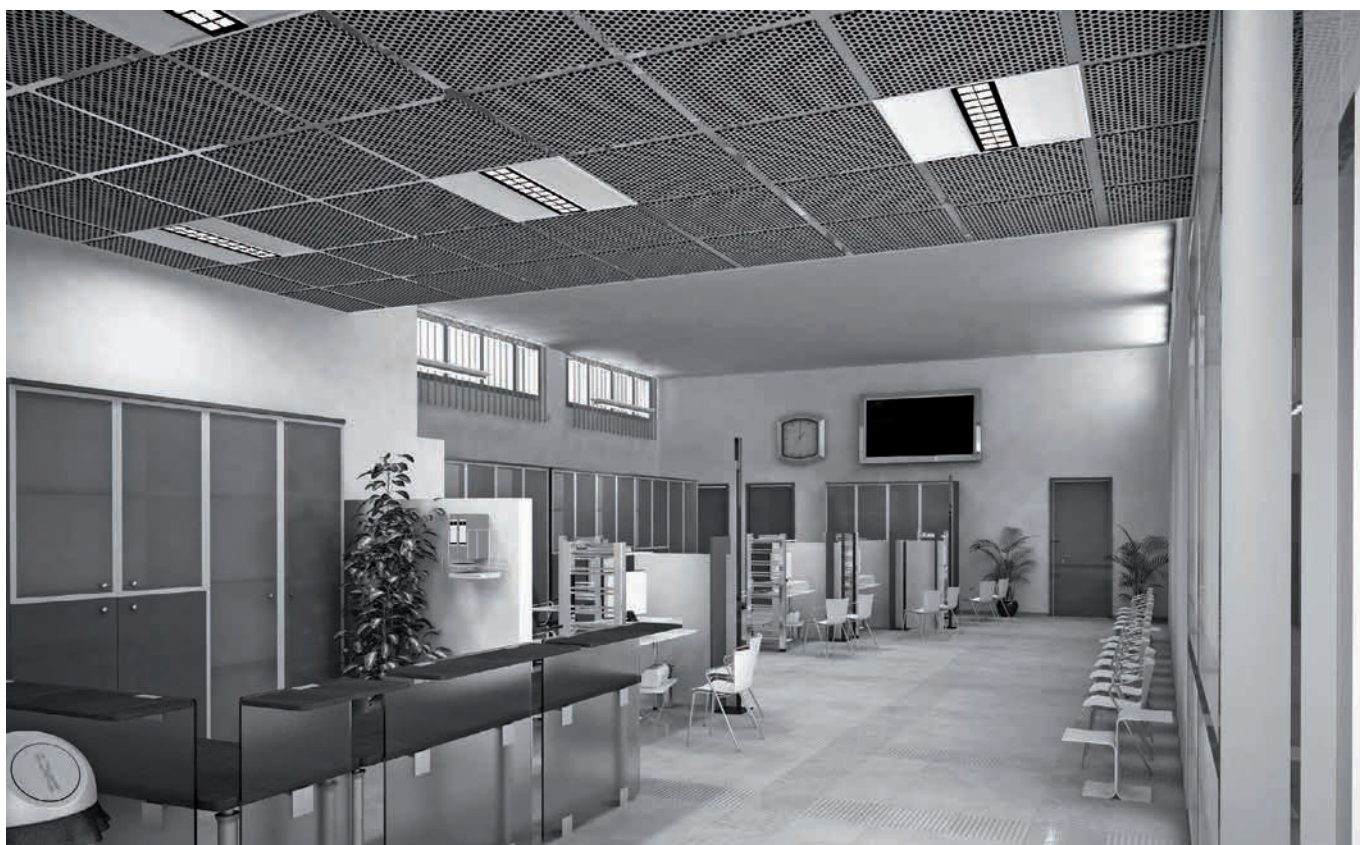
vysoce leštěná parabolická mřížka pro optimální rozložení světelného toku
